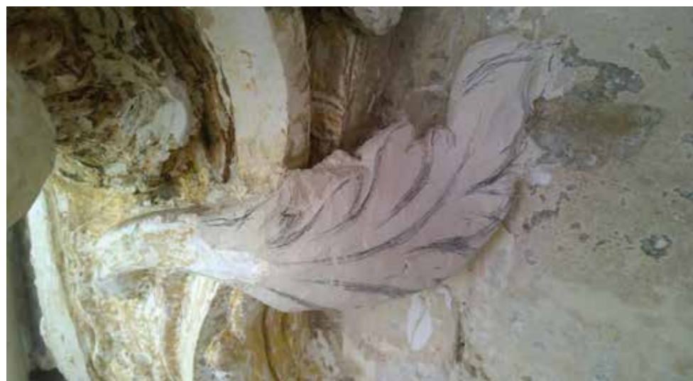
↑ Les éléments des sculptures qui avaient disparu ont été repris au plâtre.
