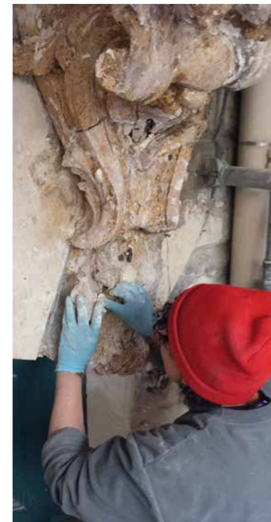
↑ Intromission d'un élément de renfort.
