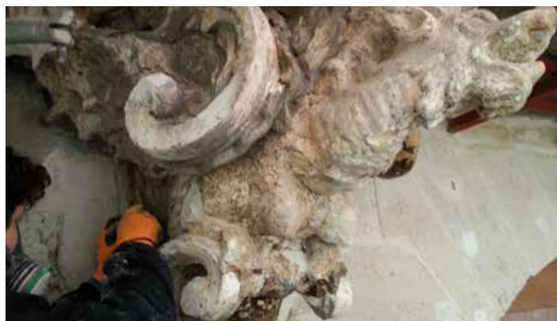
→ Les surfaces sont décapées au scalpel.
