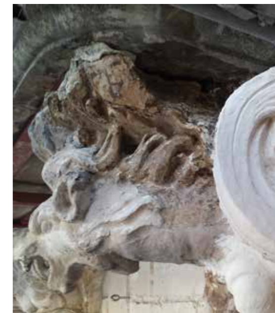
↑ Les parties originales sont complétées par des reprises si nécessaire.
